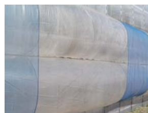
正常な状態 ダクトは膨らみ 張っている
