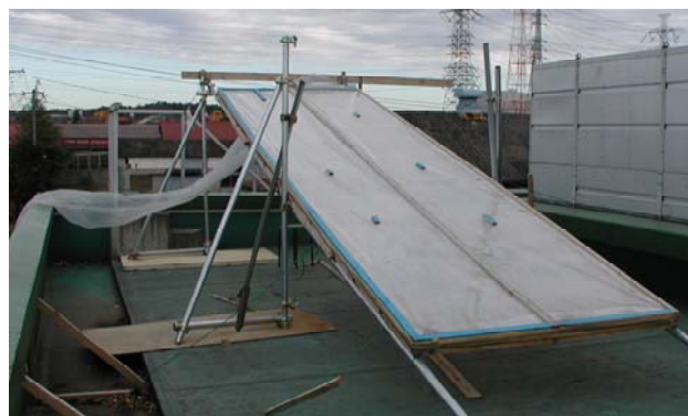
写真1 酸化チタン脱臭槽
