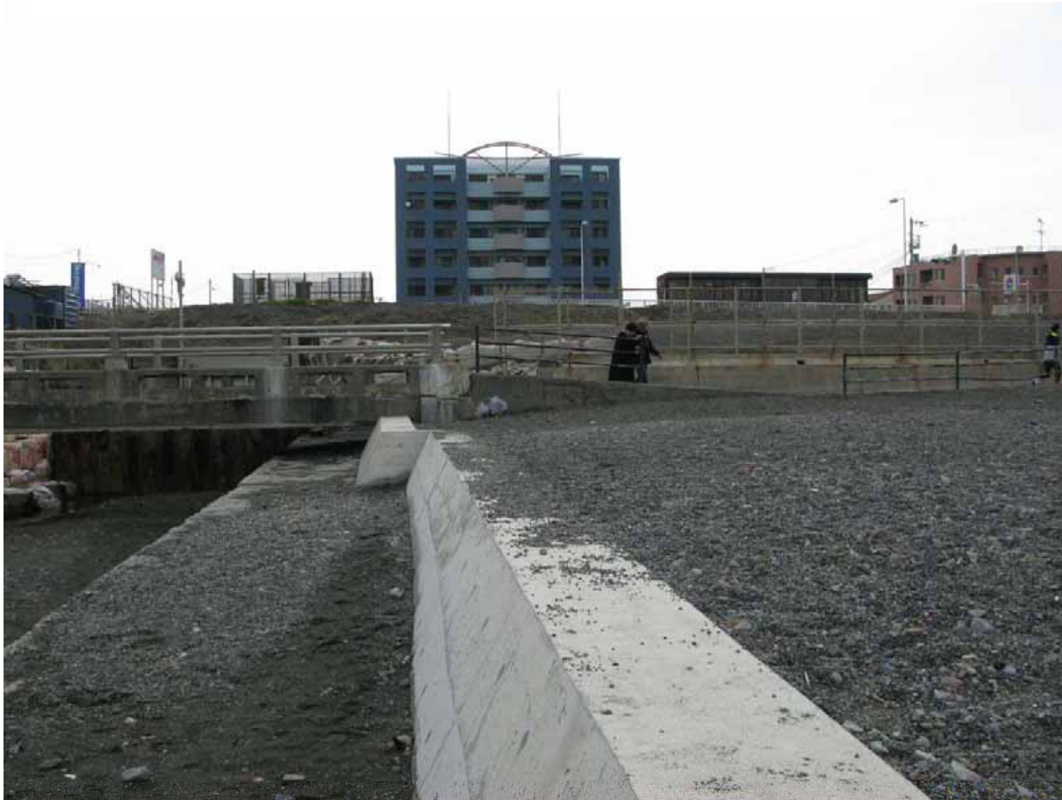
図-21 嵩上げされた6号水路の導流堤と堆砂（2015年3月31日撮影）
