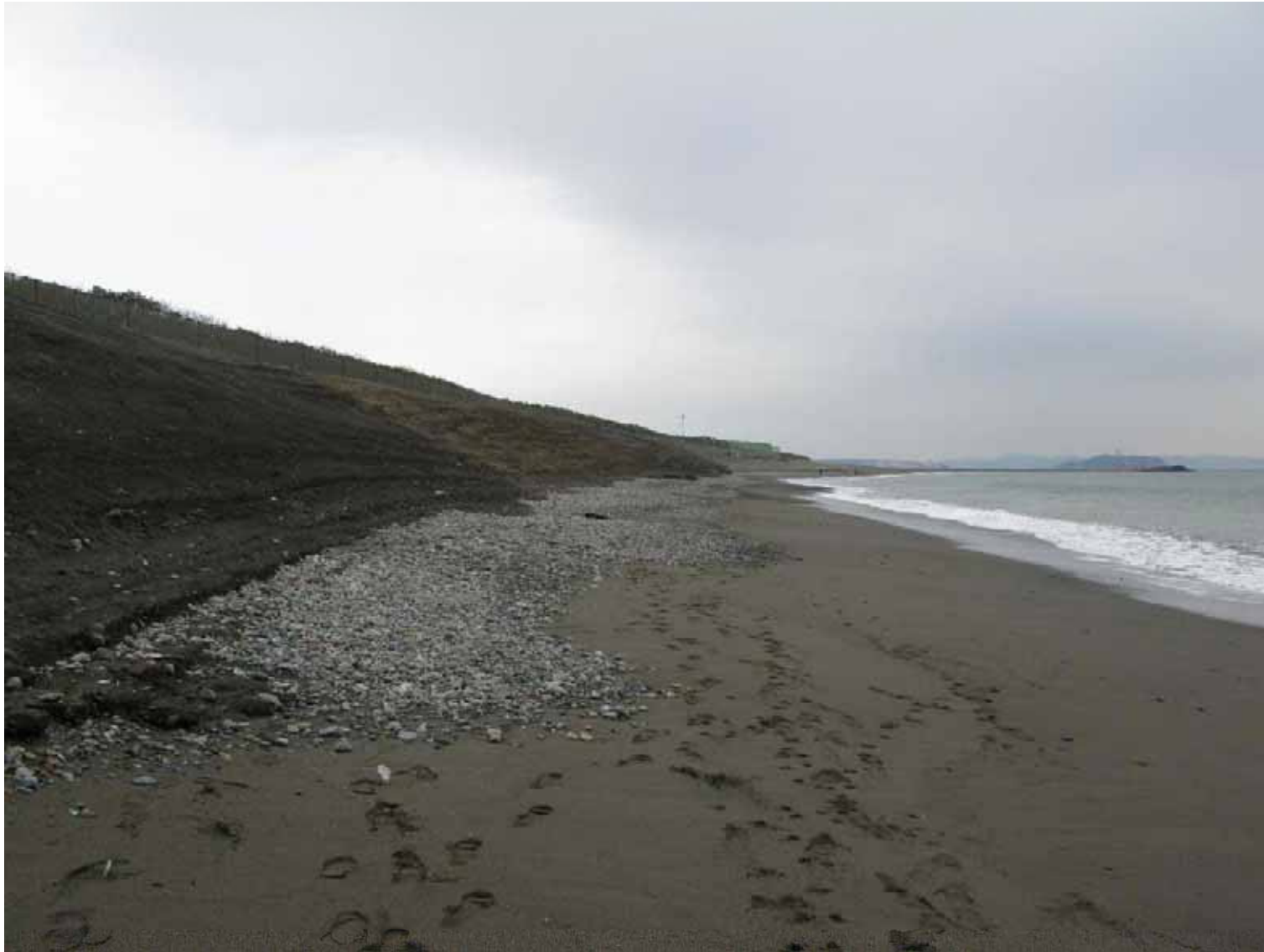
図-22 茅ヶ崎中海岸での盛り土養浜ののり先（2015年3月31日撮影）
