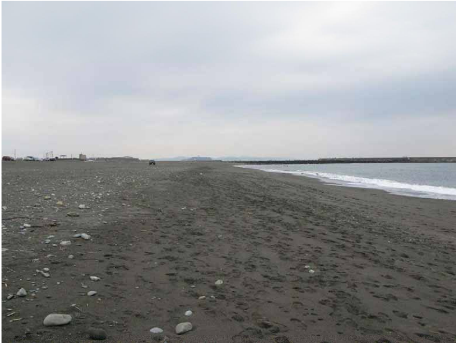
図-18 茅ヶ崎漁港の防波堤を西側から望む（2015年3月31日撮影）
