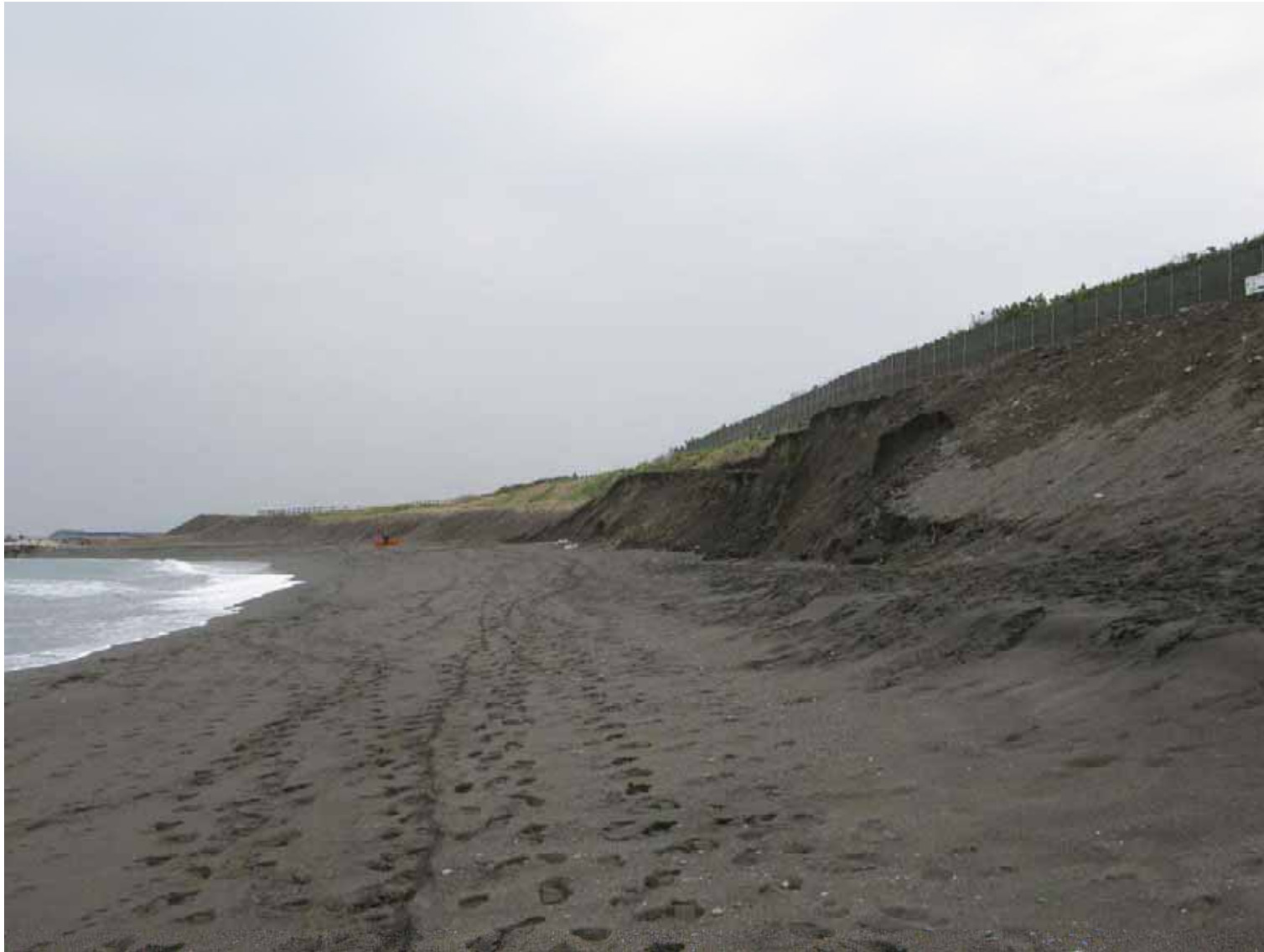
図-17 柳島の養浜箇所を西向きに望む（2015年3月31日撮影）
