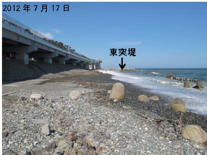
図-19 西突堤の付け根から東側を望む海岸状況（2012年7月17日）
