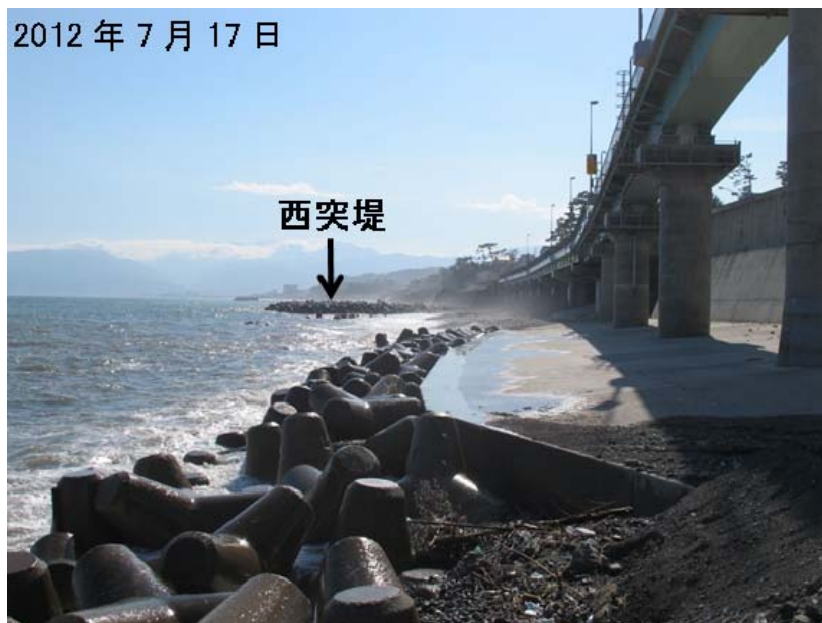
図-13 金波・銀波橋付近の養浜前の状況 (2012年7月17日)
