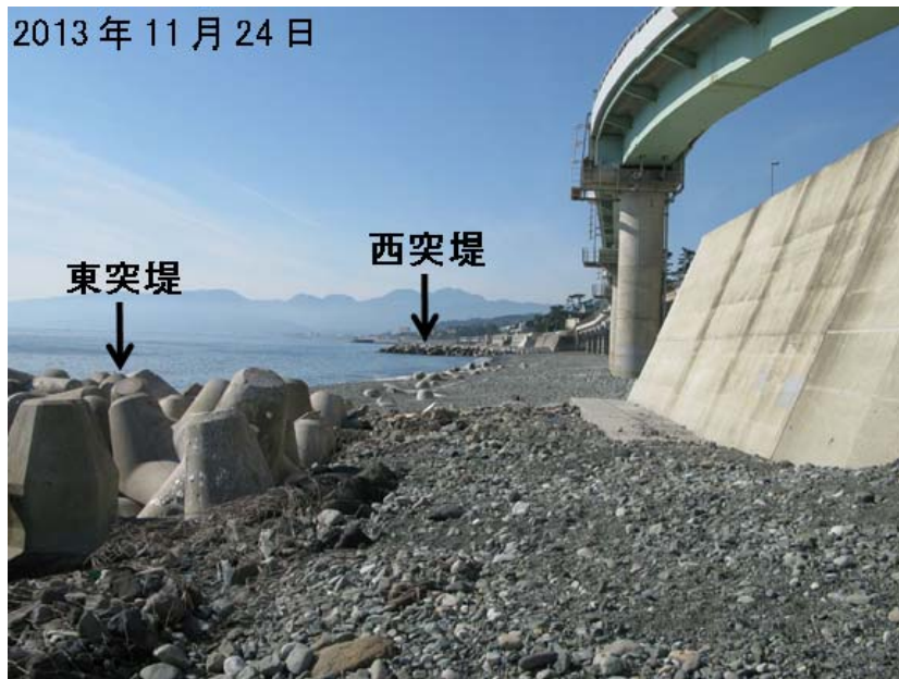
図-14 東突堤の付け根から試験養浜区間を望む（2013年11月24日）
