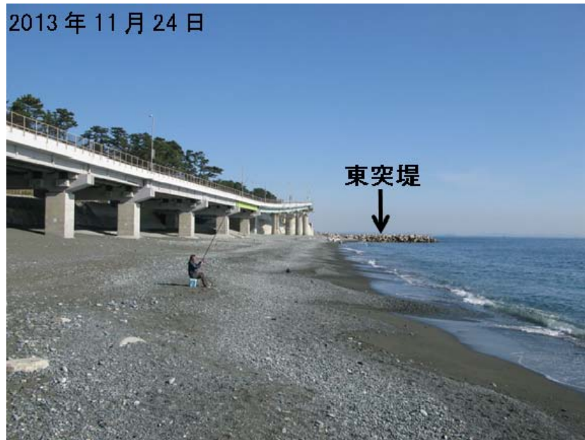
図-20 西突堤の付け根から東側を望む海岸状況（2013年11月24日）
