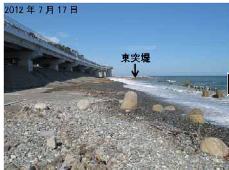
写真-14 西突堤の付け根から東側を望む海岸状況 （2012年7月17日）
