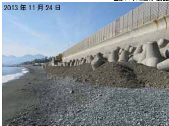
写真-19 盛り土養浜の東端部 (2013年11月24日)
