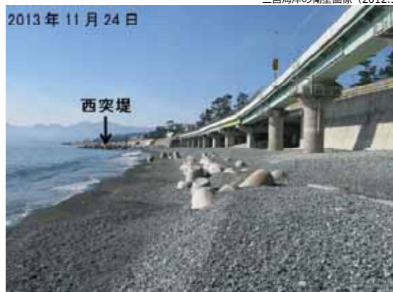
写真-7 粗粒材養浜により広がった前浜と砂礫に埋まった消波工 （2013年11月24日）
