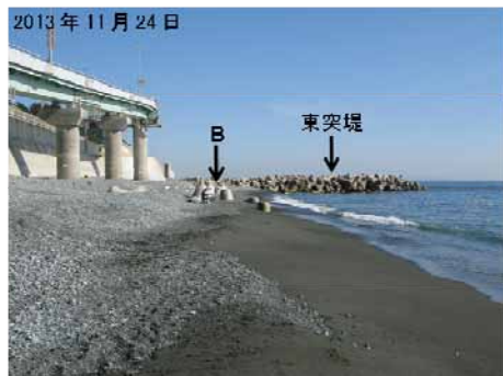
写真-10 海浜中央部から東突堤を望む （2013年11月24日）
