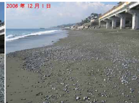
写真-13 被災前の金波橋直下の海浜状況 （2006年12月1日、神奈川県撮影）
