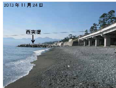
写真-12 海浜中央部から西突堤と広がった前浜 （2013年11月24日）
