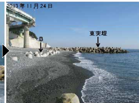
写真-9 東突堤と養浜により広がった前浜 （2013年11月24日）
