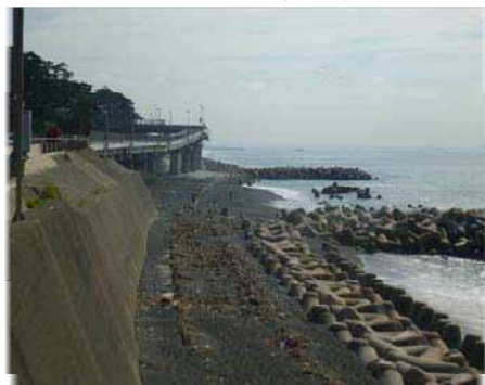
図-22 突堤2基の建設と粗粒材養浜開始(2012年8月17日撮影)
