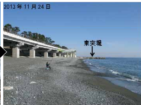
写真-15 西突堤の付け根から東側を望む海岸状況 （2013年11月24日）
