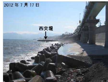
写真-4 金波・銀波橋付近の養浜前の状況(2012年7月17日)
