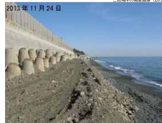
写真-20 盛り土養浜の天端部分 (2013年11月24日)
