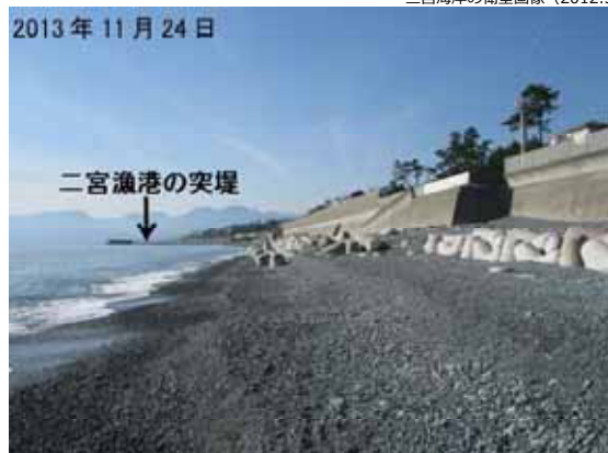
写真-17 西突堤隣接部から二宮漁港方面を望む （2013年11月24日）
