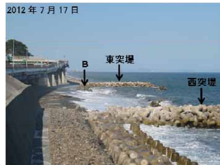
写真-8 養浜開始時の試験区間の状況 （2012年7月17日）
