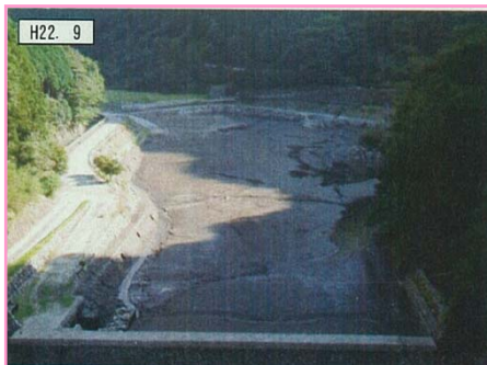
写真 H22.9洪水前後の河内貯砂 ダムの土砂堆積状況
