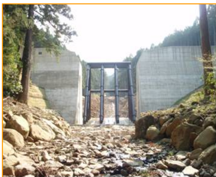
写真 透過型砂防堰堤 (酒匂川水系 大雄川)
