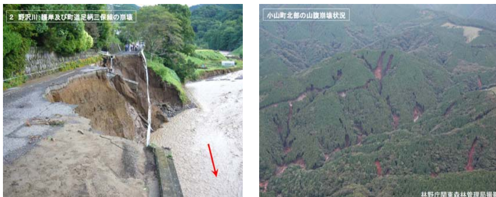
写真9 台風第9号による被害状況(静岡県小山町)
