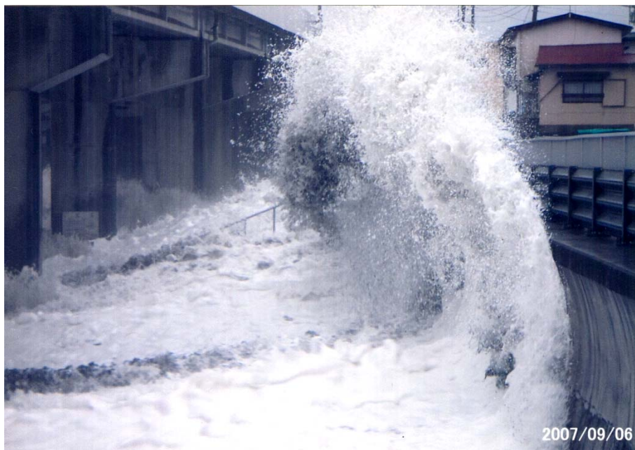
図-25 台風9号来襲時の越波状況(住民の方より提供)
