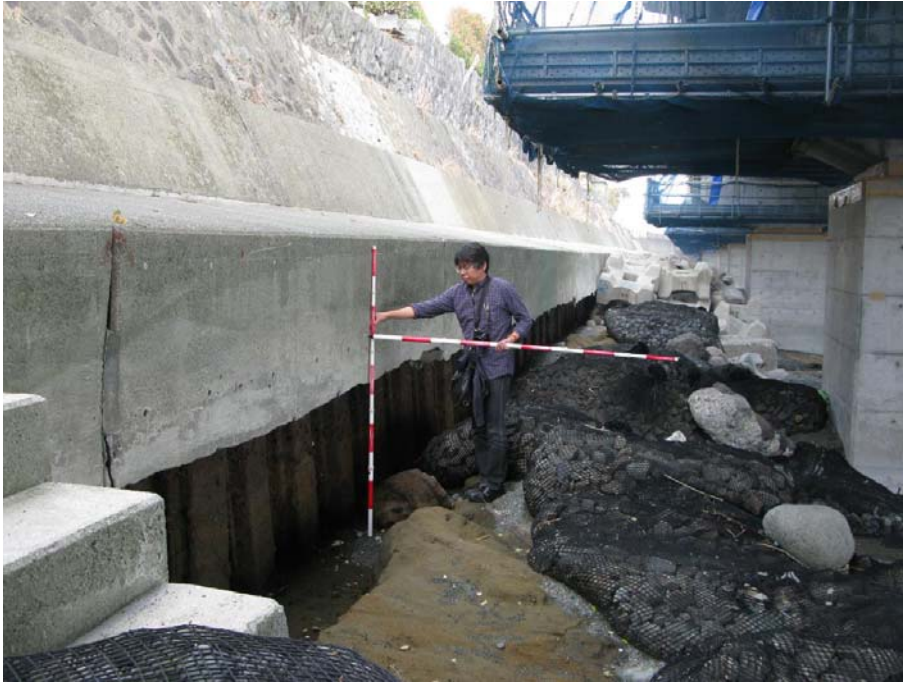
図-17 護岸のコンクリートフーチング下部では長い範囲にわたって高さ約1mの矢板が露出
