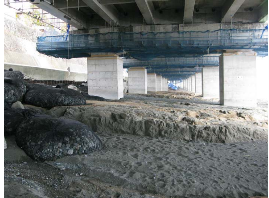
図-18 西湘バイパスの橋梁区間直下における基盤岩の露出状況
