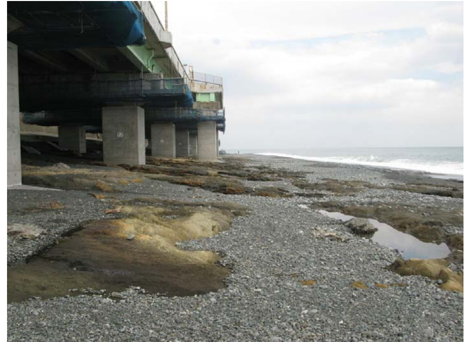
図-16 前浜に小高いバームを形成して堆積していた砂礫が消失し、基盤岩が広い区域で露出
