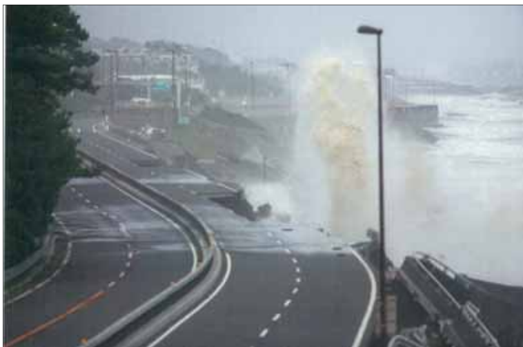
【西湘バイパス】
