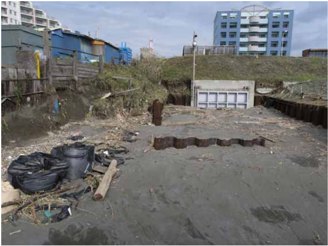
写真-2 盛り土区間（砂）上に残された遡上痕跡
