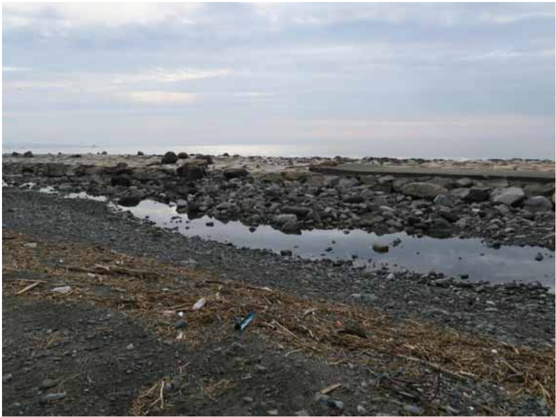
写真-4 消波堤の天端を越えて陸側に運ばれた基礎捨石
