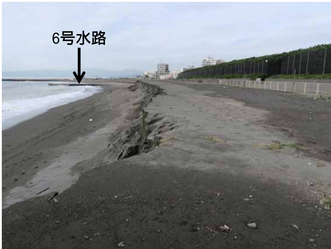
写真-4 砂養浜区間の全体状況
