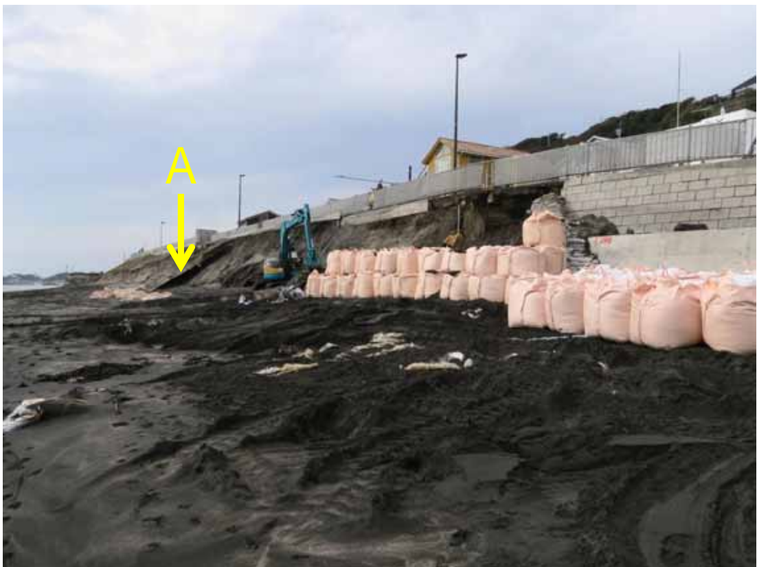
写真-10 国道134号線が著しく侵食された場所での大型土嚢の設置状況
