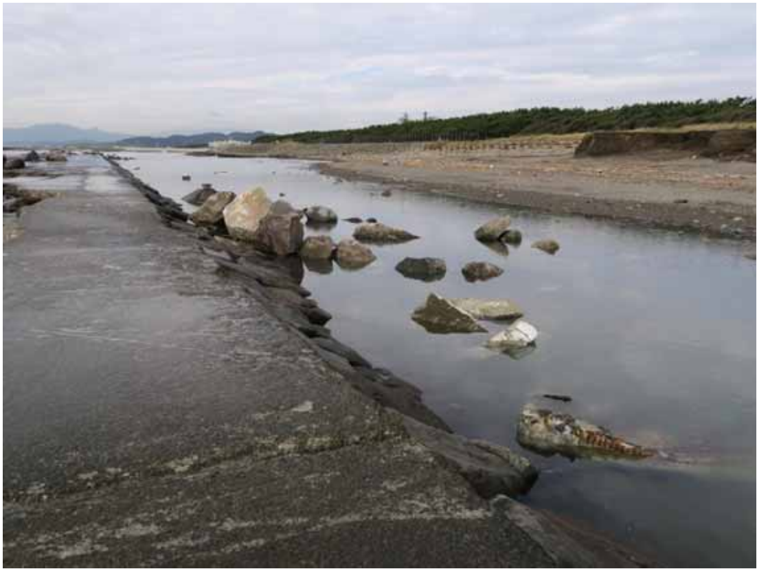
写真-2 消波堤の天端を越えて陸側に運ばれた基礎捨石
