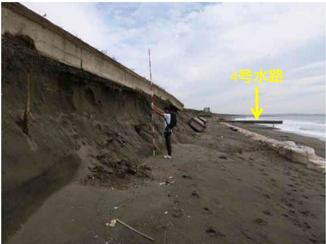
写真-4 直下にオーバーハングができて崩落寸前のボードウォーク（地点4）
