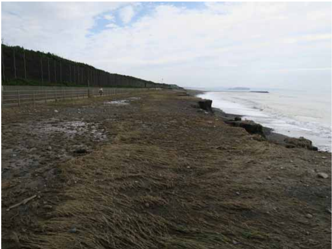
写真-3 盛り土区間（粗粒材）上に残された遡上痕跡
