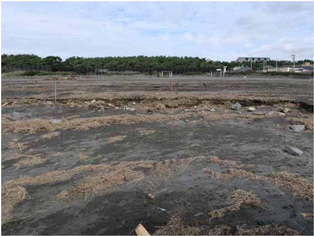
写真-12 茅ヶ崎漁港の西側に隣接する駐車場からの砂の流出
