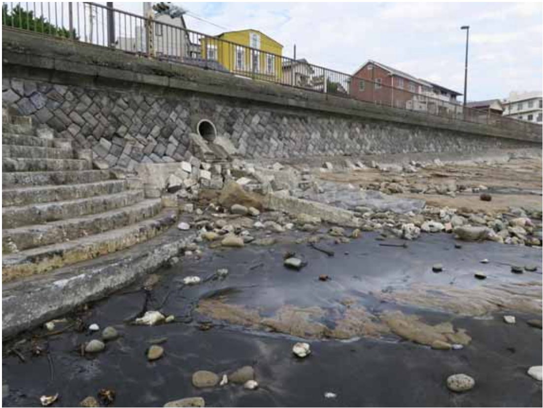
写真-13 バラバラに東側に散乱した石段
