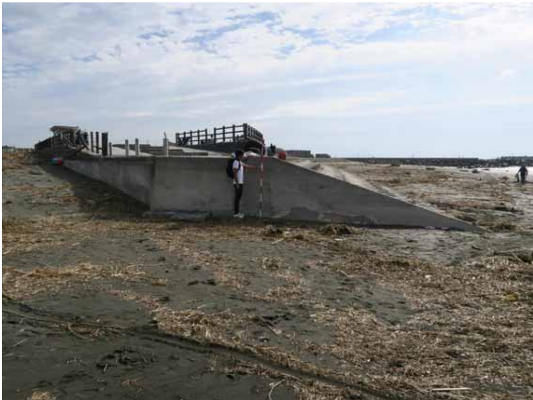
写真-11 茅ヶ崎漁港の西側に設置されている傾斜護岸の端部
