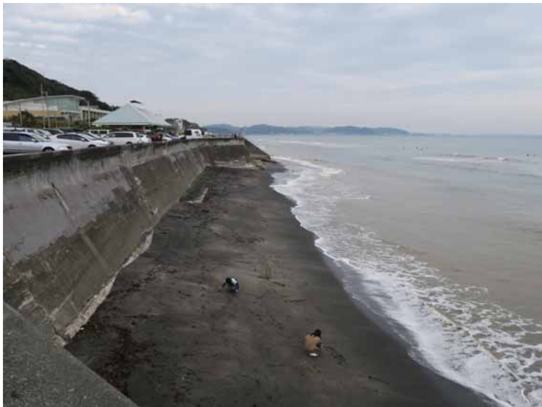
写真-2 地形変化の見られない駐車場中央部
