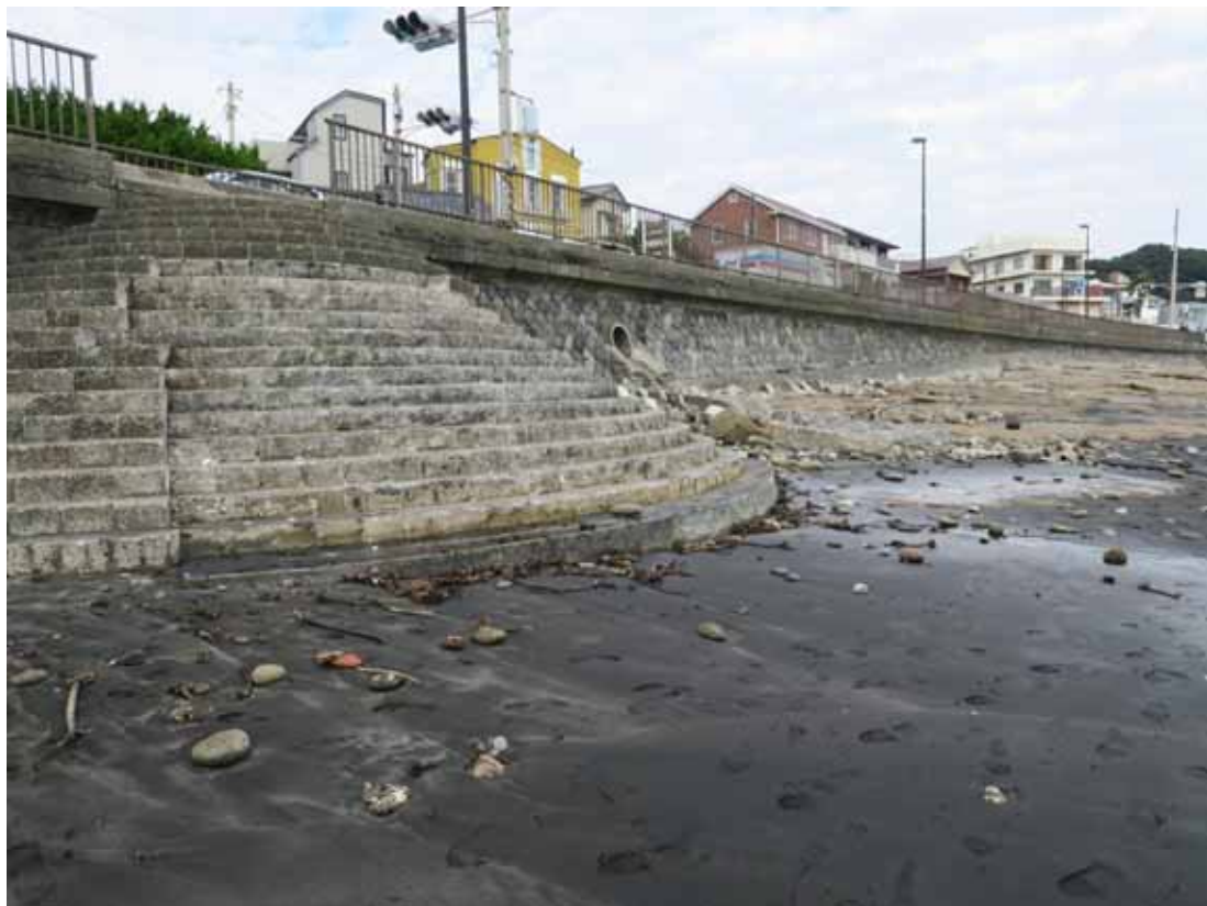
写真-12 石段がはげ落ちた円形階段
