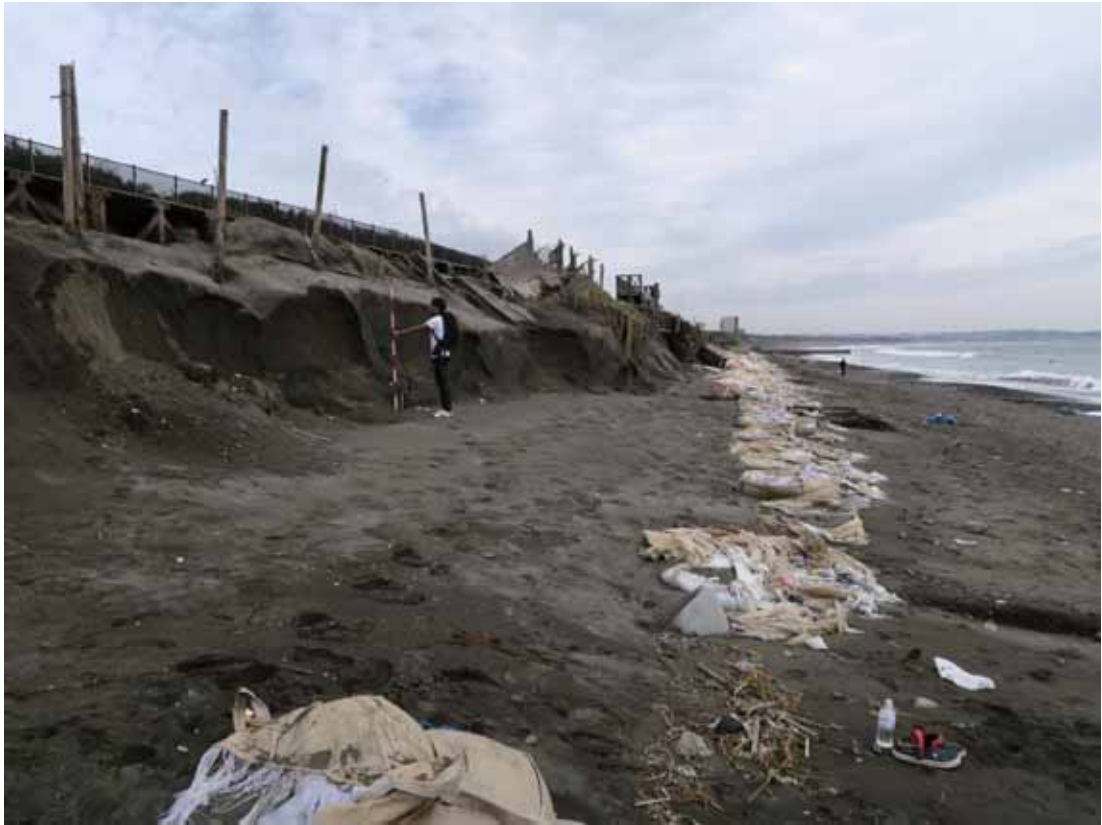
写真-1 盛り土養浜の海側斜面にできた比高約1.7 mの浜崖 (茅ヶ崎ヘッドランドの東420 mの地点1)
