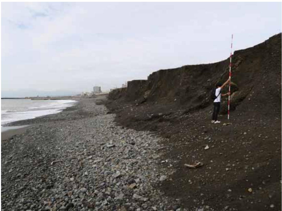
写真-7 盛り土区間に形成された比高約3 mの浜崖
