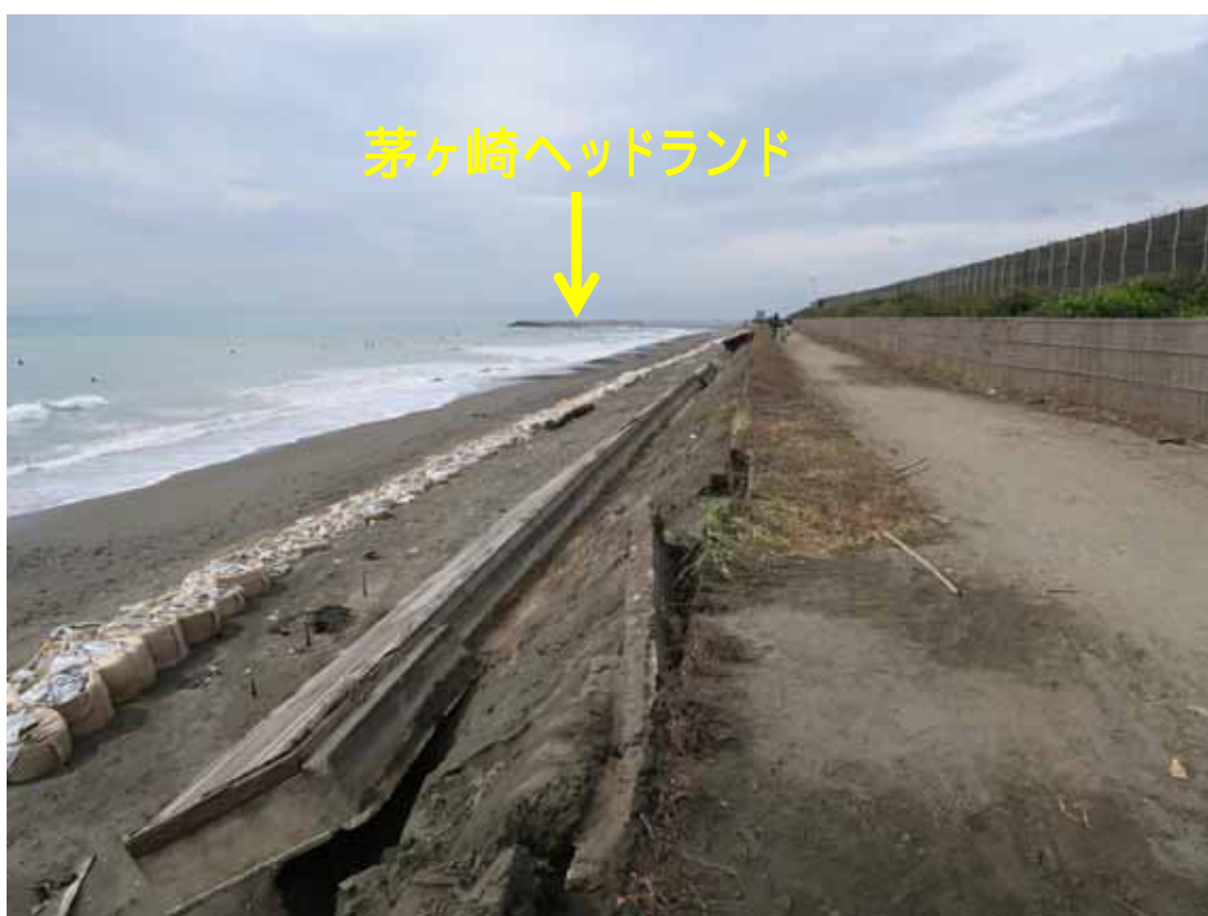
写真-6 4号水路の西側直近の遊歩道上から西向きに遊歩道全体を撮影（地点6）
