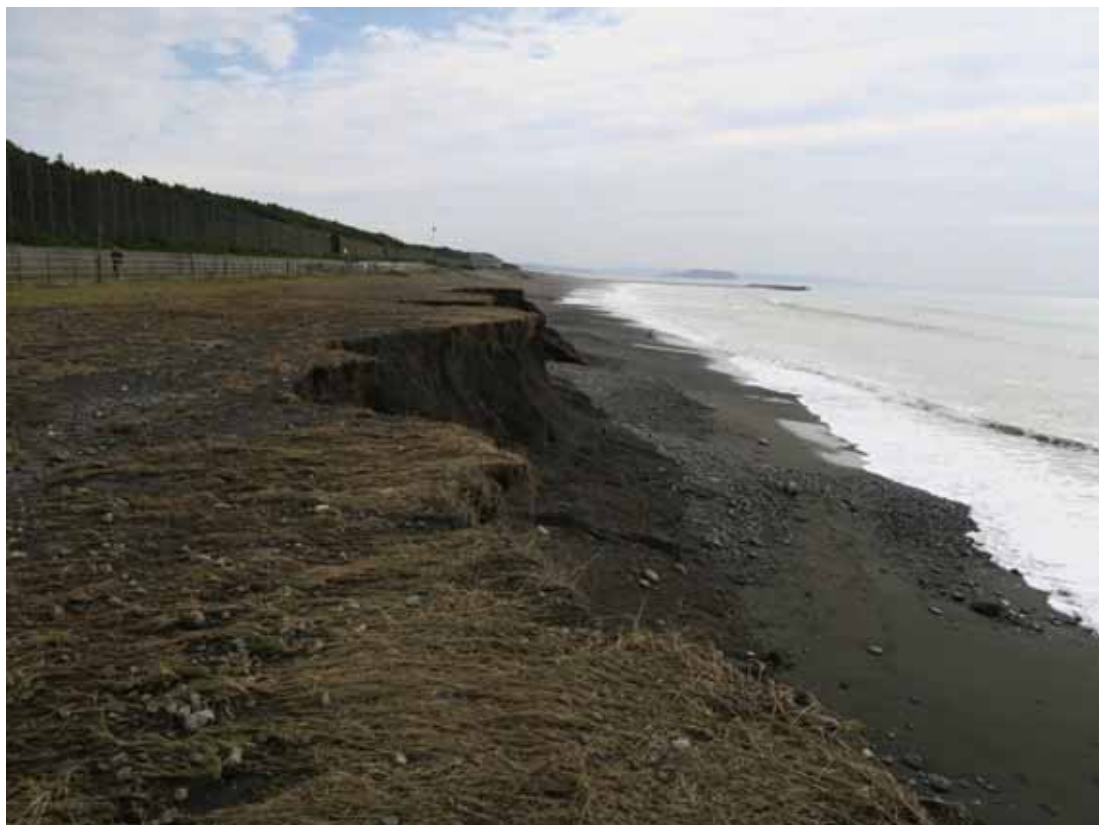
写真-5 粗粒材養浜区間に残された遡上痕跡
